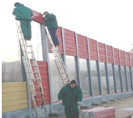
Ręczny montaż paneli aluminiowych
