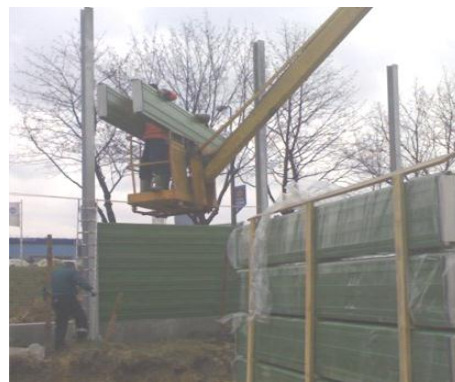
Montaż paneli aluminiowych przy użyciu windy
